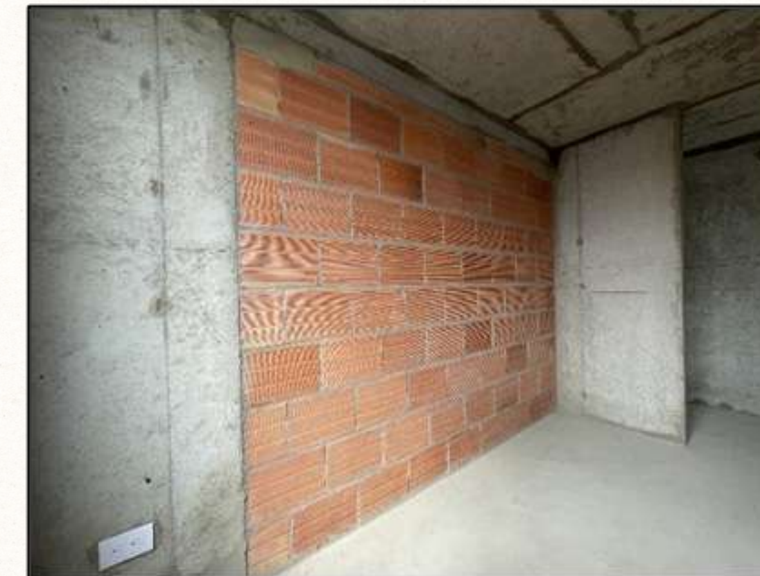
Ilustración 15 - Muros en concreto y mampostería
