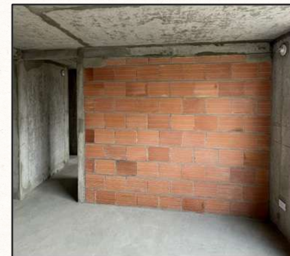
Ilustración 12 - Muro de mampostería en sala-comedor
