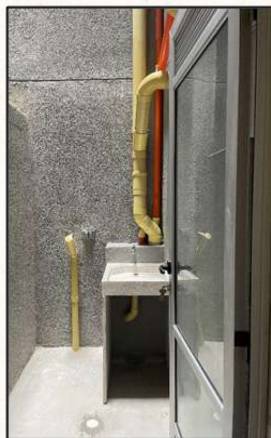
Ilustración 31 - Puerta de Patio Primeros Pisos
