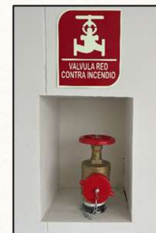
Ilustración 8 Válvula red contra incendio
