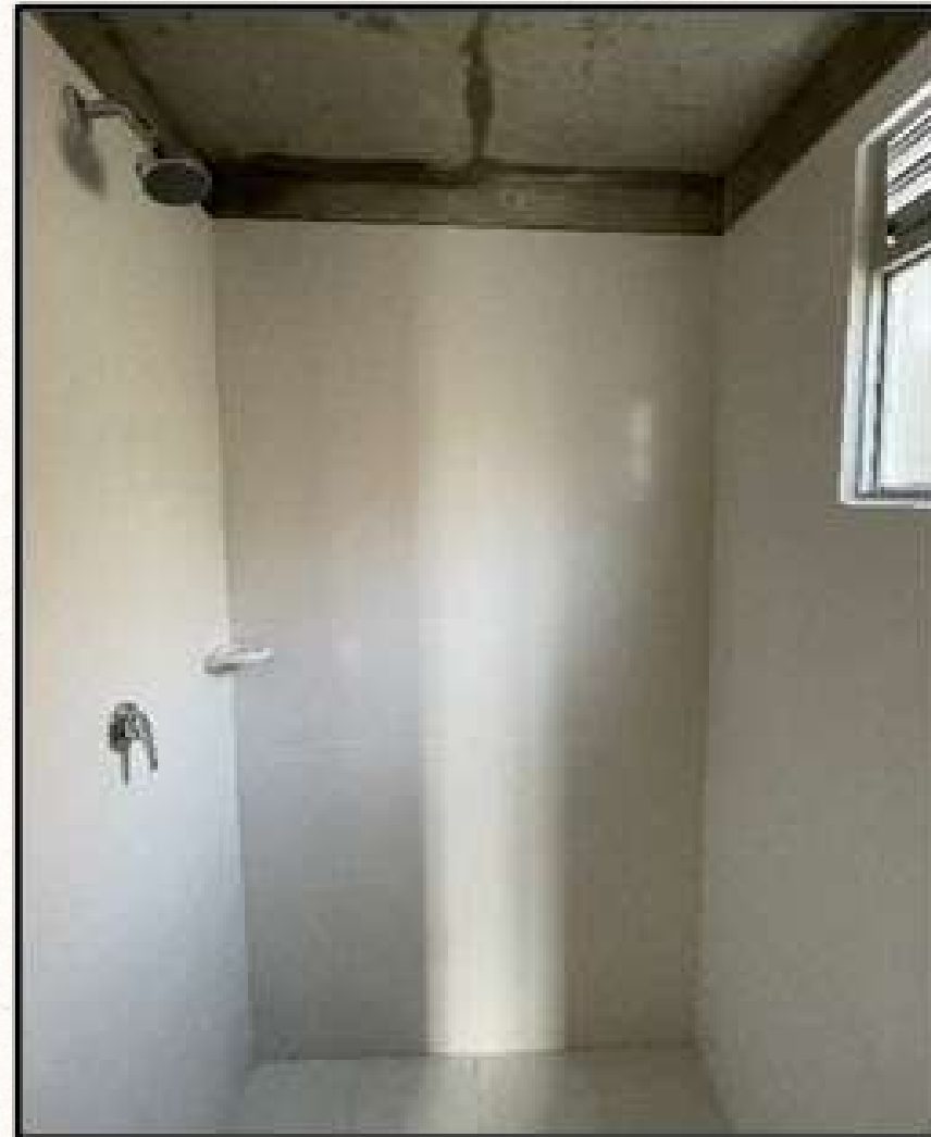
Ilustración 18 - Piso y Muros de ducha
