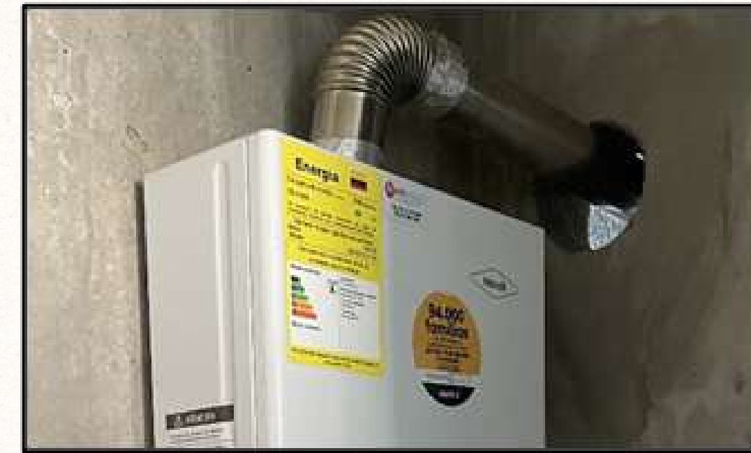
Ilustración 5 - Ubicación pase para calentador
