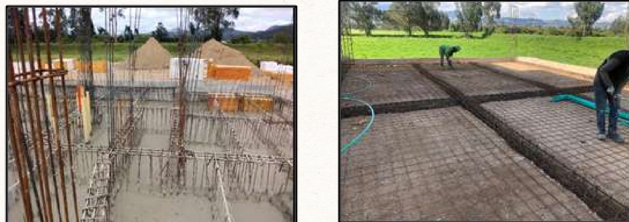
Ilustración 2 - Cimentaciones torres y comunales
