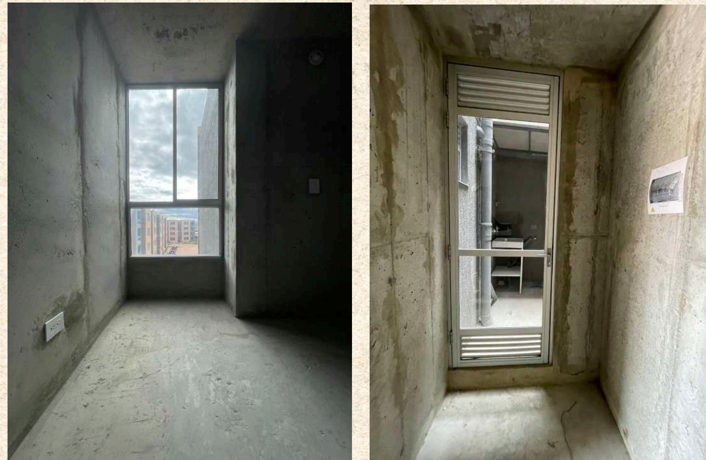
Imagen 29 y 30. Ventana y Puerta ventana en Aluminio (patios 1er, Piso)
