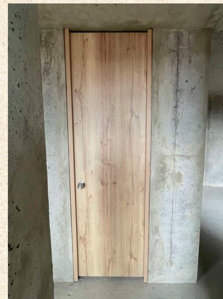
Imagen 33. Puerta en Melamínico
