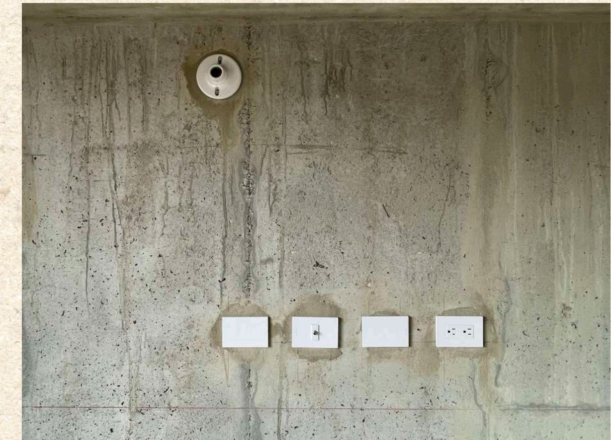
Imagen 15. Caja disponible para toma telefónica
