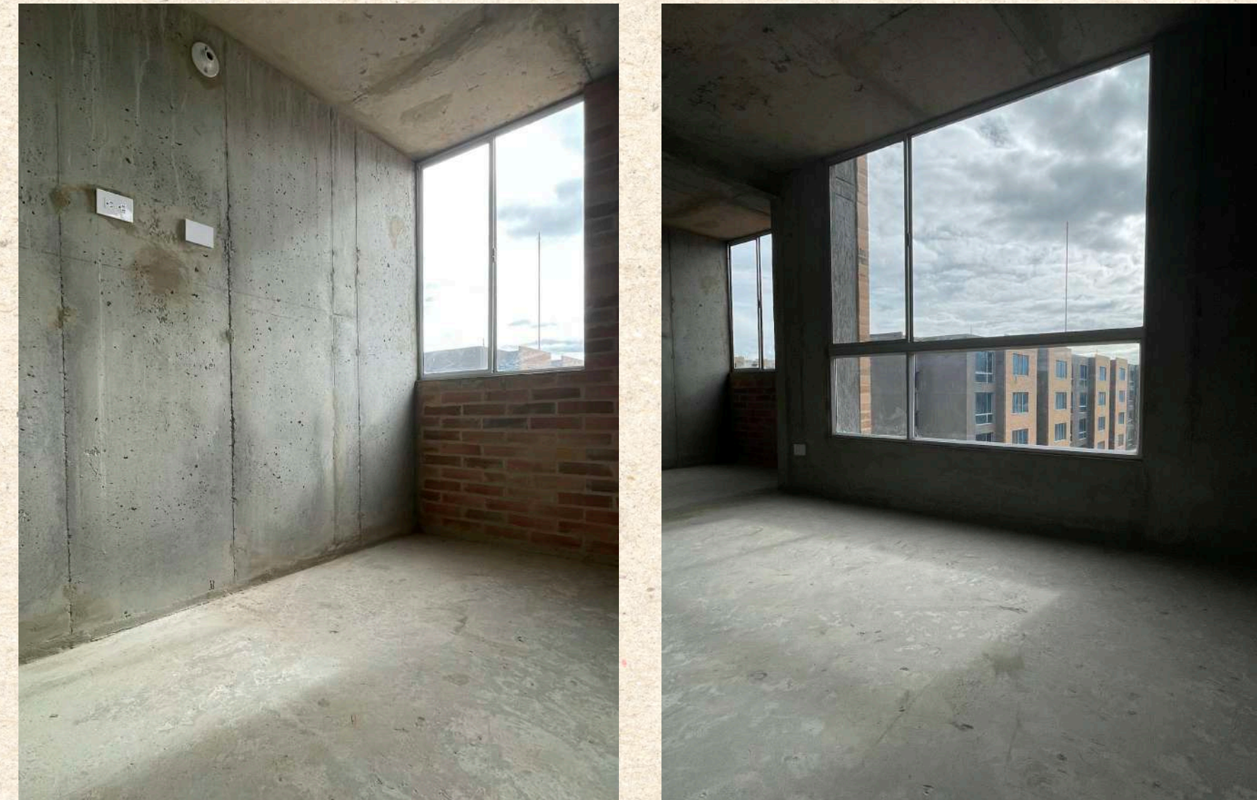
Imágenes 27 y 28. Pisos y Cielorrasos en concreto
