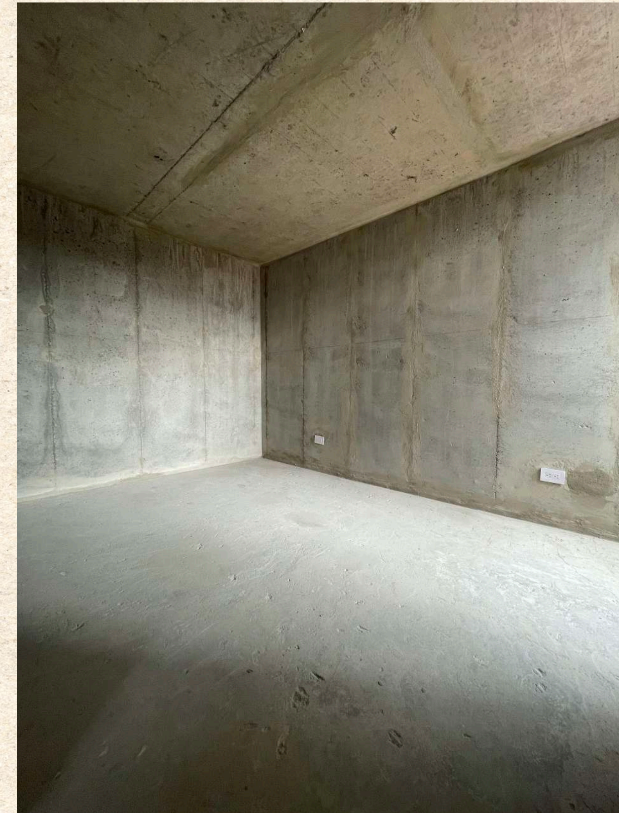
Imagen 6. Placas en concreto
