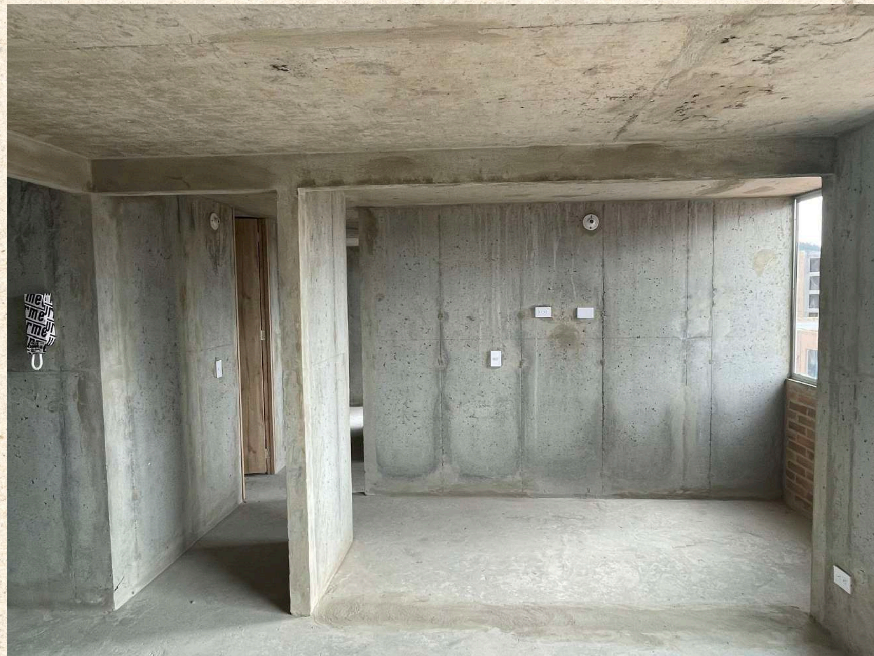
Imagen 19. Espacio para muro de mampostería en sala-comedor
