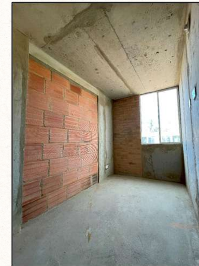
Ilustración 28 - Pisos y techos en concreto
