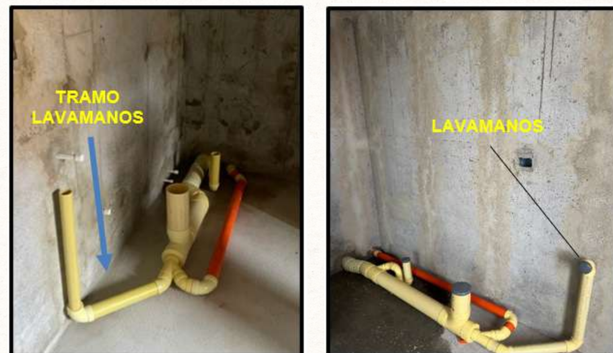
Ilustración 18 - Adecuación baño, paso 4
