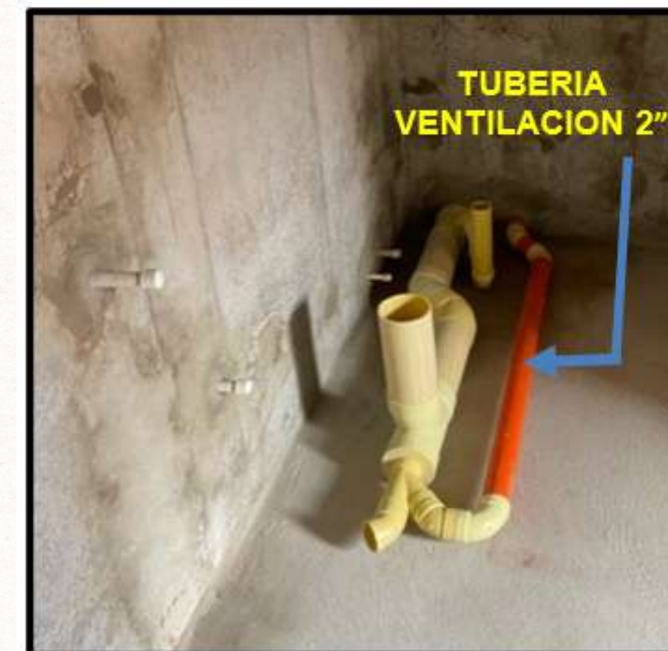
Ilustración 19 - Adecuación baño, paso 5
