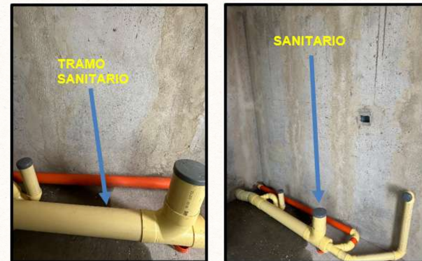
Ilustración 17 - Adecuación baño, paso 3
