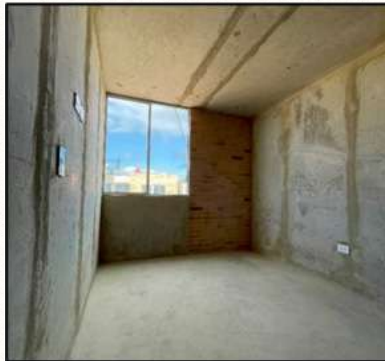
Ilustración 22 - Muros en concreto y en mampostería
