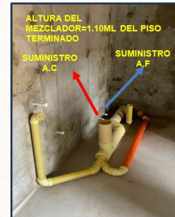
Ilustración 21 - Adecuación baño, paso 6b
