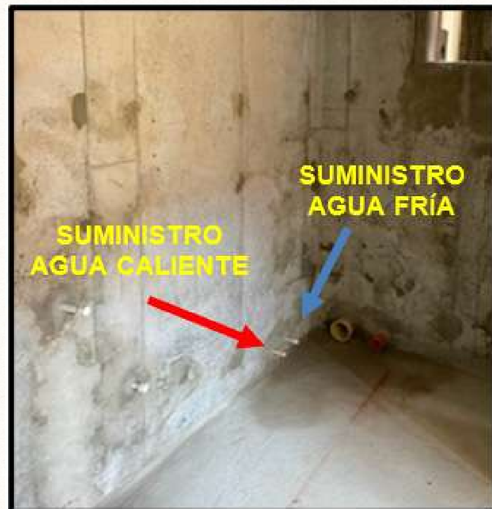
Ilustración 20 - Adecuación baño, paso 6a
