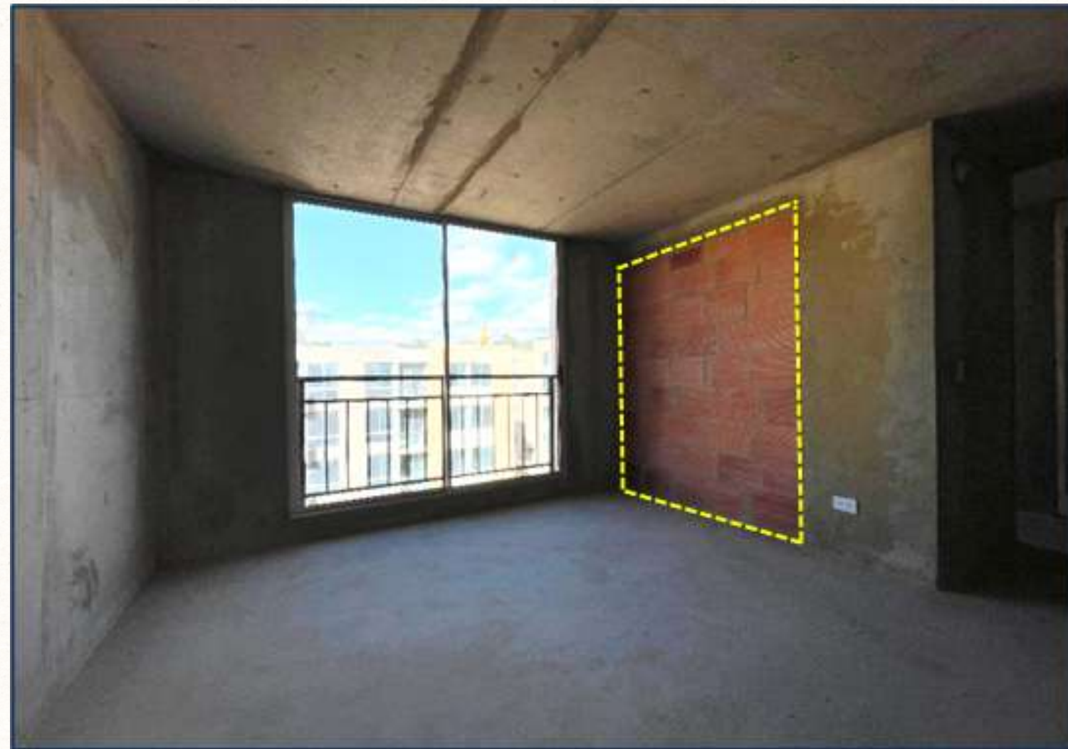
Ilustración 13 - Espacio para remover muro divisorio
