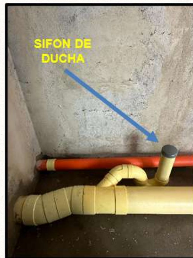
Ilustración 16 - Adecuación baño, paso 2
