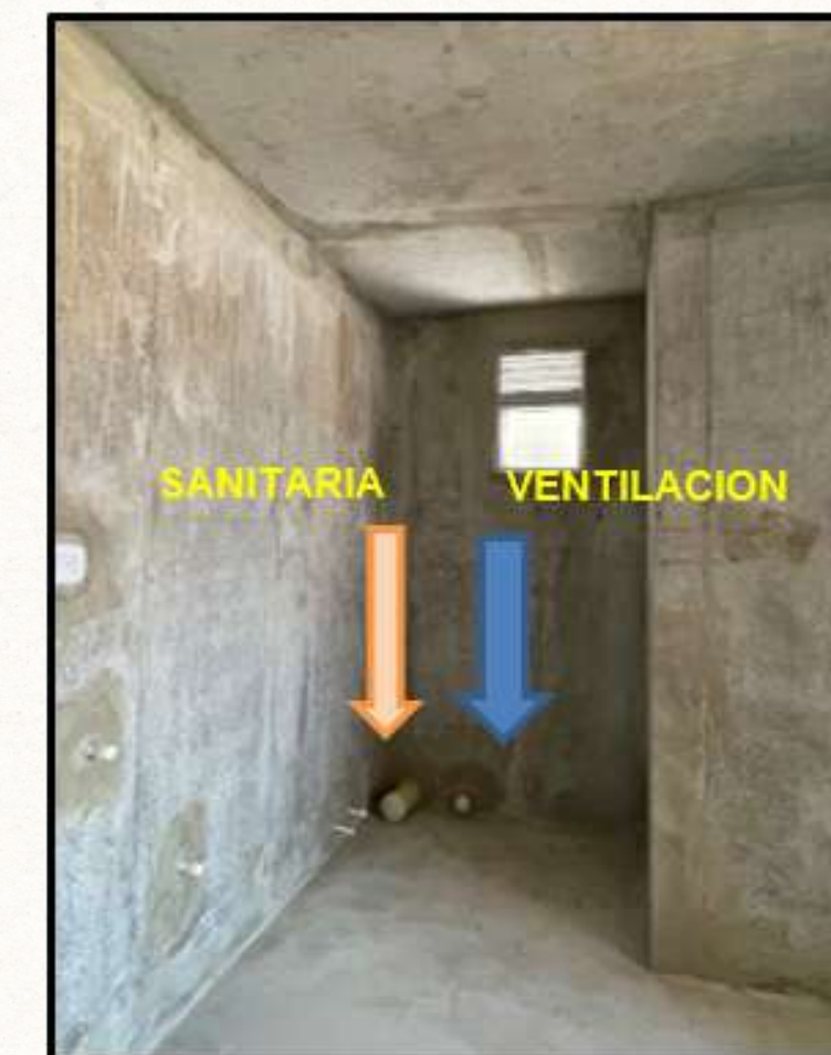
Ilustración 15 - Adecuación de baño, paso 1
