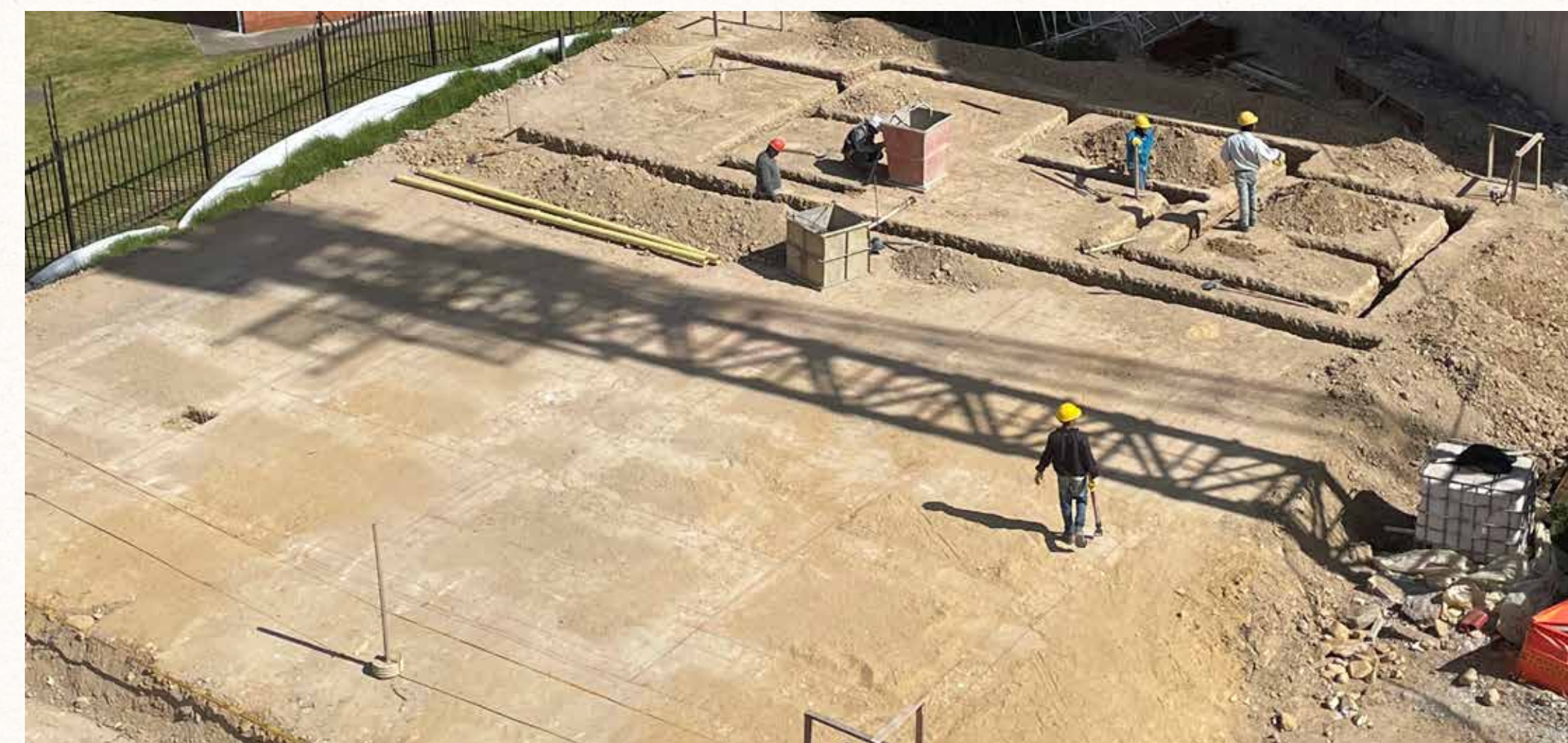
Ilustración 6 - Vista etapa de construcción
