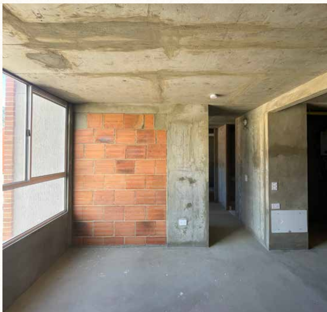
Imagen 20. Vista sala y techo apartamento
