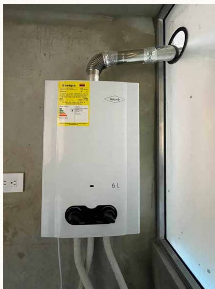
Imagen 12. Calentador de agua a gas
