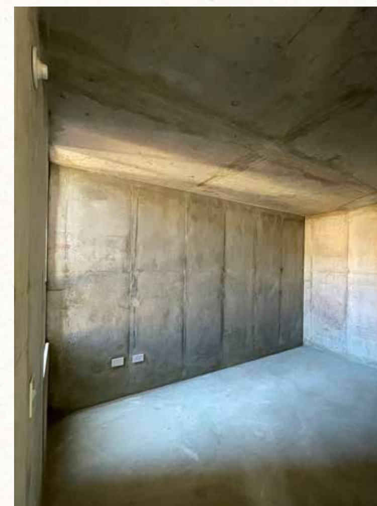
Imagen 19. Muros en concreto
