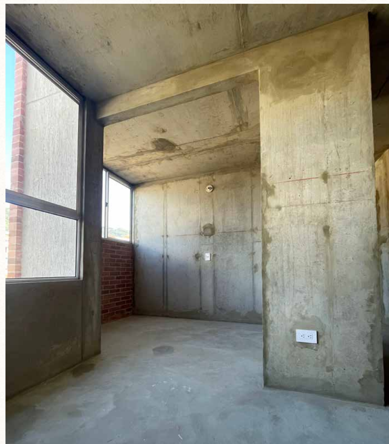
Imagen 27. Muro de mampostería en sala-comedor, alcoba
