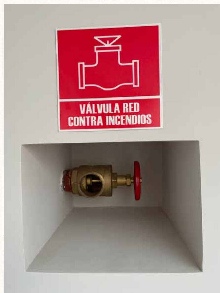
Imagen 10. Toma para manguera, exclusiva para cuerpo de bomberos
